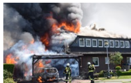
Innerhalb von Minuten stand auch das Dach in Flammen.
